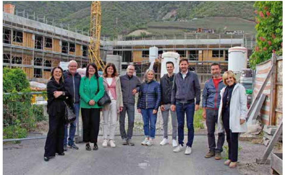
Landesrätin Waltraud Deeg überzeugte sich gemeinsam mit dem Gemeindeausschuss und dem Verwaltungsrat des Seniorenwohnheims vom aktuellen Baufortschritt beim Projekt „Begleitetes Wohnen“.
