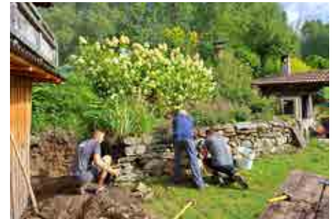
Mitglieder bei Instandhaltungsarbeiten in der Vereinsanlage.
