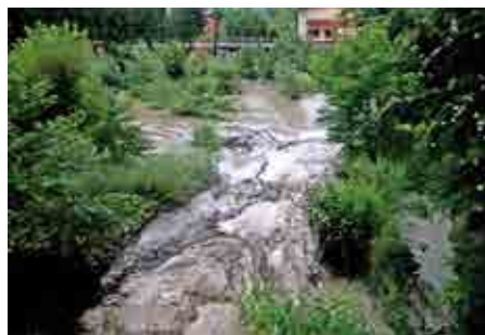
In kurzer Zeit war das Rückhaltebecken merklich mit Material aufgefüllt. Die vorbereiteten Maßnahmen haben sich aber wiederum bewährt.
