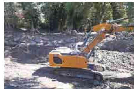
Dank der guten Zusammenarbeit zwischen Amt für Wildbachverbauung und den Grundeigentümern konnten die Räumungsarbeiten schnell durchgeführt werden.
