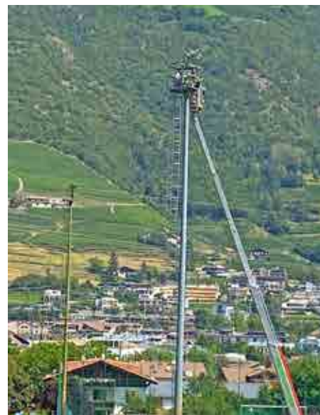
Installation der neuen LED-Beleuchtung am Trainingsplatz in der Naturner Sportzone. (Foto SSV Naturns)
