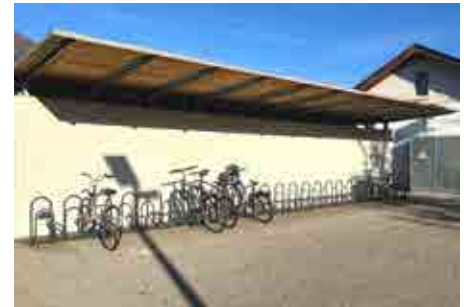
Die neue Radabstellanlage am Bahnhof von Naturns
