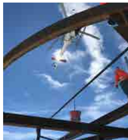
Beim Bau der Aussichtsplattform
