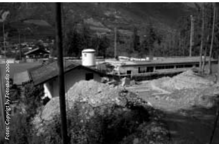
Nordansicht der Baustelle
