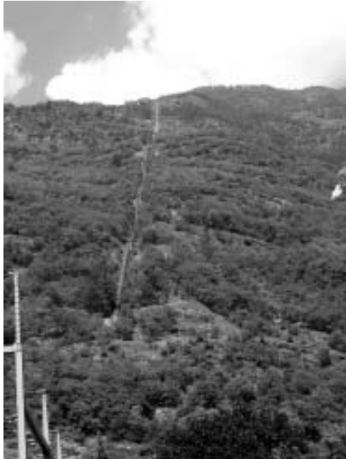
Wie eine Narbe „ziert“ die Wasserleitung den Naturnser Sonnenberg
