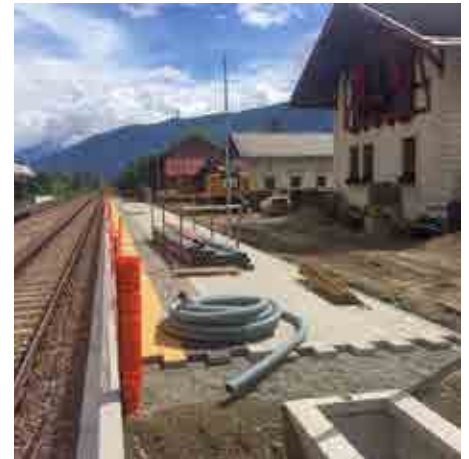
Die Bauarbeiten am neuen Bahnhof Staben schreiten zügig voran. (Foto: STA/Cagol)
