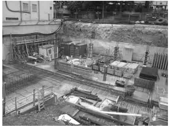
Erstmals wird in Naturns ein Gebäude mit zwei unterirdischen Garagengeschossen errichtet.
